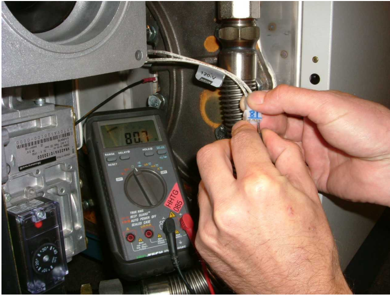
48. Ábra A forrófelületű gyújtó ellenállásának ellenőrzése (150c/160he/ 200c/220he/ 250c)
