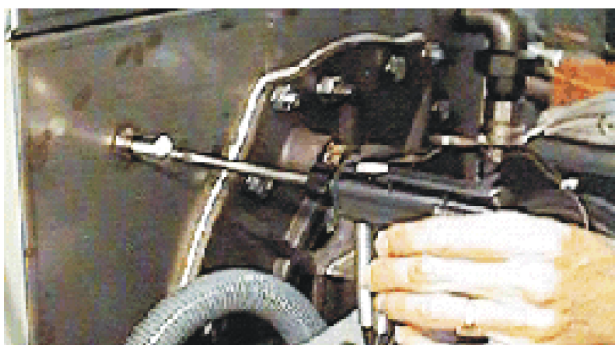
53. Ábra A mintavételező szonda behelyezése
